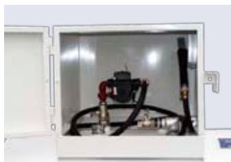
Åbent pumpebeskab
